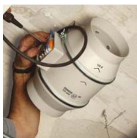
Réaliser les connections.
