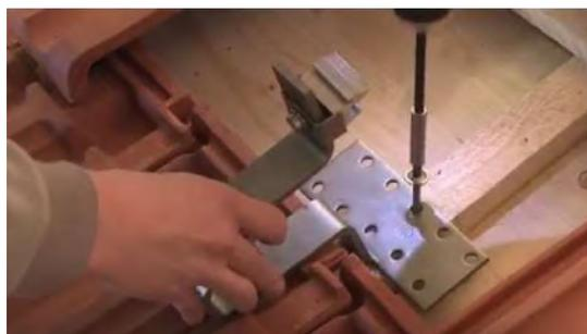
**Figure 2 – Pose d'un crochet Rapid2+ 45**
