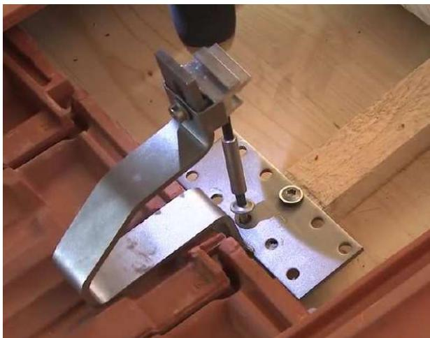
Figure 17 – A gauche : Fixation d'un crochet par deux vis
