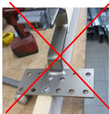
Figure 32 - Essai de fixation de crochet sur un arbalétrier de fermette trop fin
