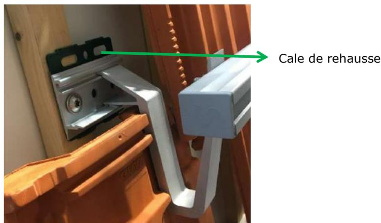
Figure 30 - Crochet avec cale de rehausse
