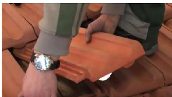
**Figure 27 - Partie de tuile à retirer**
