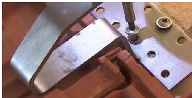
**Figure 24 - Mise en position du crochet sur tuile**
