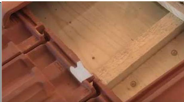
**Figure 23 - Partie de tuile à retirer**
