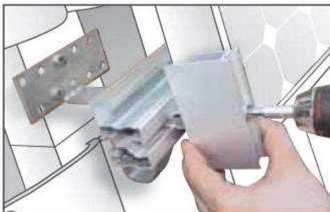
Figure 45 - Clipsage et serrage de la pince
