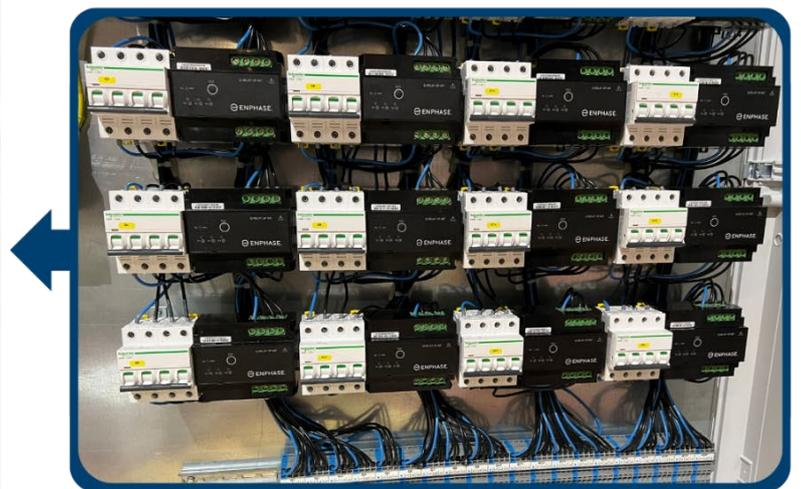
Figure 35 : Coffret AC triphasé 250 kW 20 circuits Enphase triphasés 20 QR triphasés
