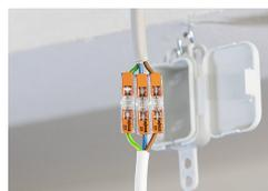
Raccordement de luminaires dans les faux-plafonds
